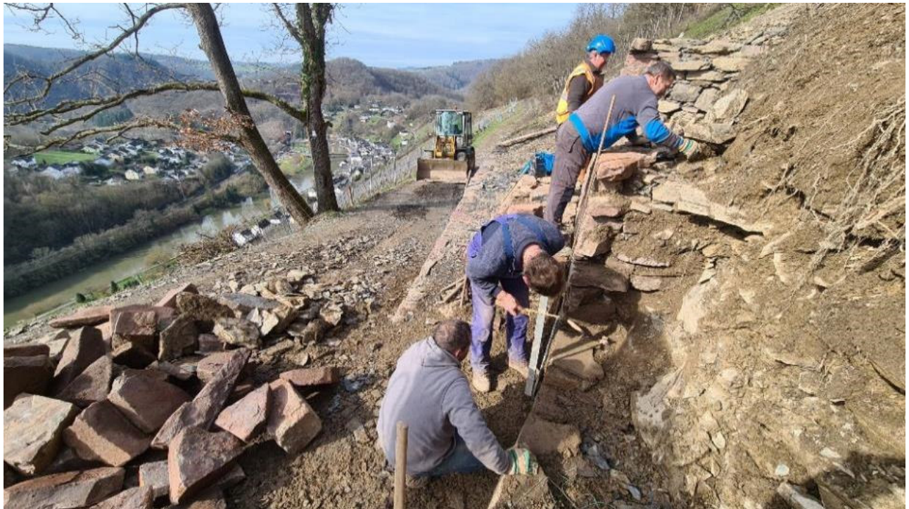
Abb. 10: Arbeiten an einer Naturschutzmauer durch den VTG
